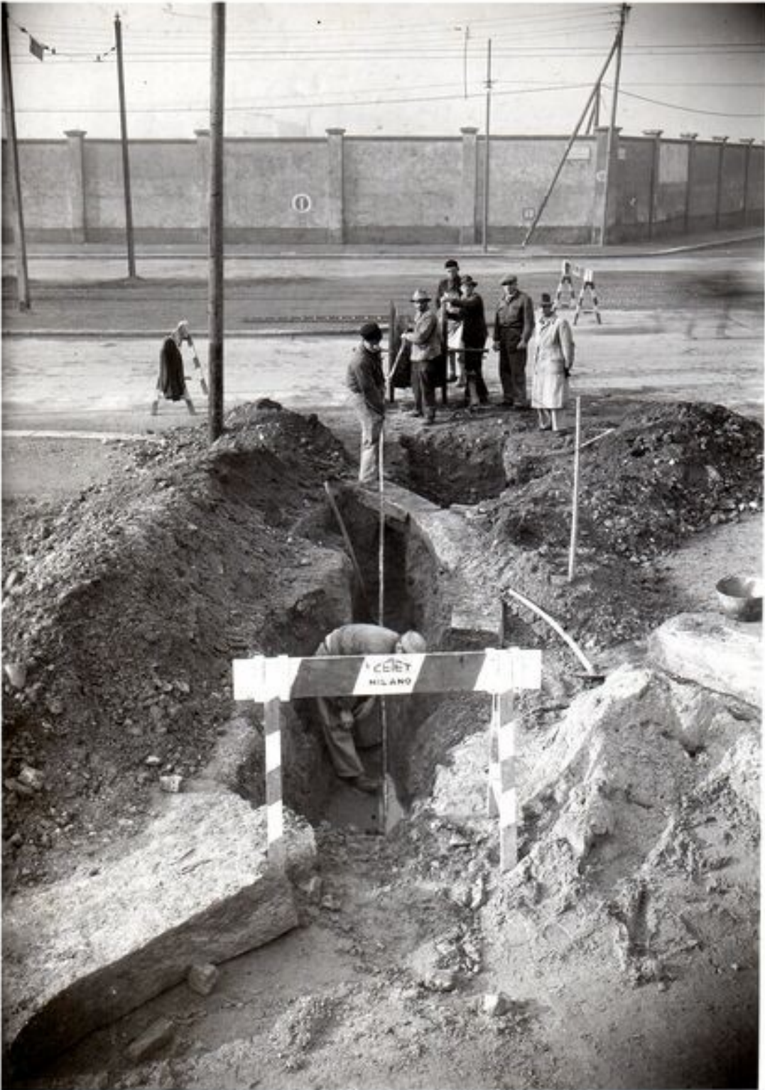
Posa del cavo Milano – Melegnano eseguito dalla Società C.E.I.E.T. Milano . Foto dicembre 1947
